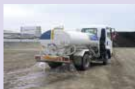
浮島地区埋立作業地 での散水の様子
