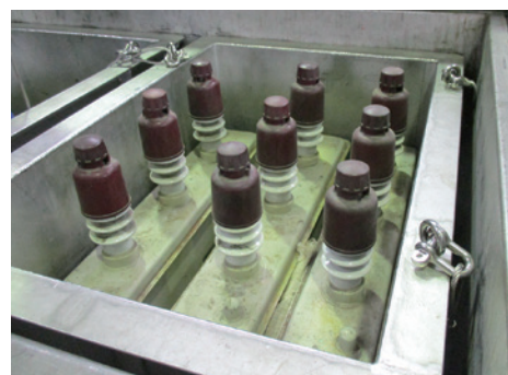
高濃度PCB高圧コンデンサの搬出
