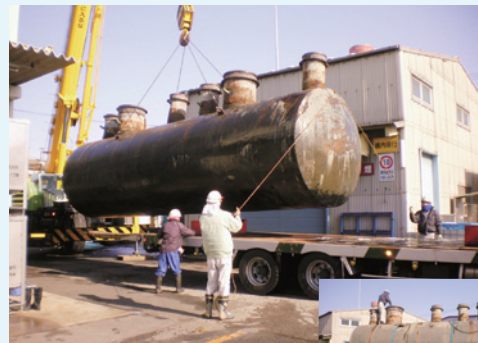
重油地下タンク撤去の様子
