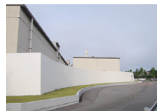
建て屋外周防潮壁 (仙台工場)
