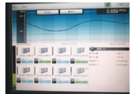
台数制御装置パネル
