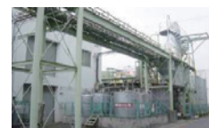
排水処理設備の排水配管の更新（基山工場）
