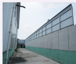
防音壁の設置 (中国 多瑪得(上海)精細化工)
