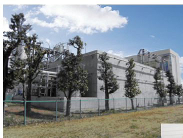
排水処理設備の更新 (石岡工場)
