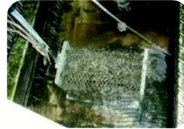
シリカ除去装置を取り付け
