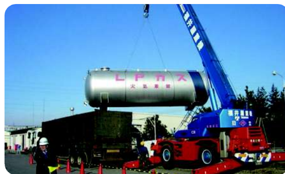
LPGタンク撤去工事
