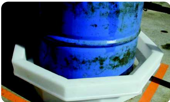
廃油ドラム缶（トレー設置後）
