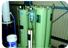
油水分離装置
