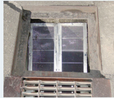
ペレット捕集用スクリーン設置例 （雨水枡）
